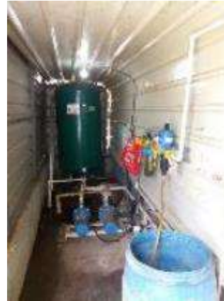
Área de dosificación y tanques de presión
